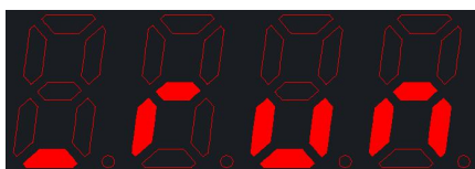
1#水泵运行(不使用互感器)
