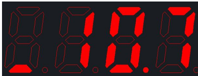
1#水泵电流值 (单位: A)
